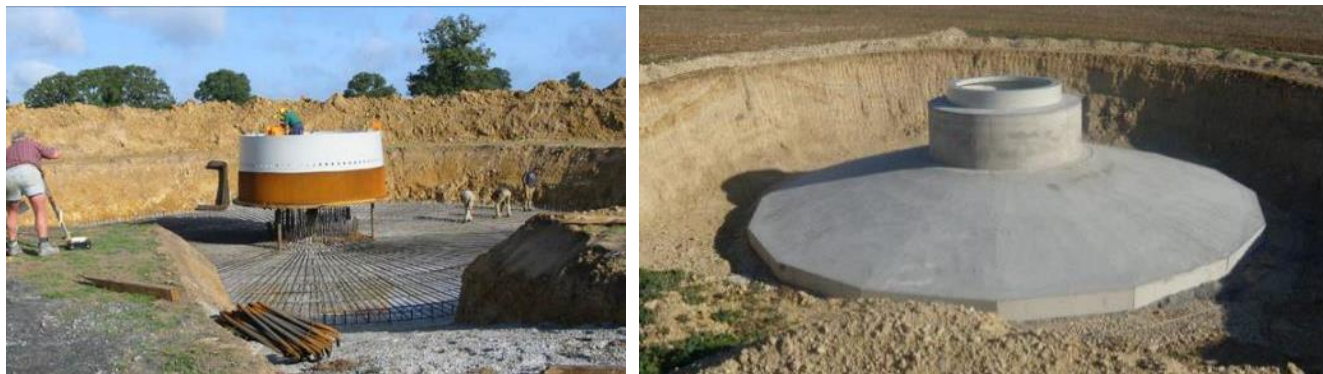
Figure 4 : Le ferrailage et le coulage d'une fondation d'éolienne
